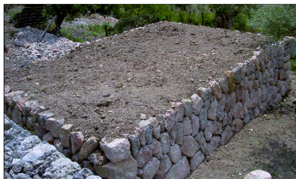
Fotografia 28 - Marjada aïllada amb funció de lisímetre.
