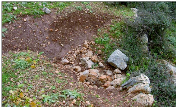
Fotografia 17 - Erosió afavorida per l'esbaldrec.
