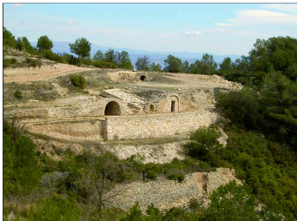
Fotografia 6 - Obres de restauració.
