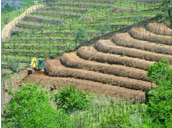
Fotografia 8 - Construção de taludes em terra.
