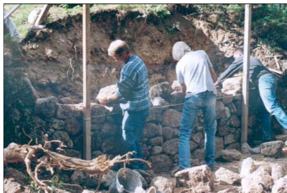
Photo 12 - Démonstration de montage d'un mur en pierre sèche.
