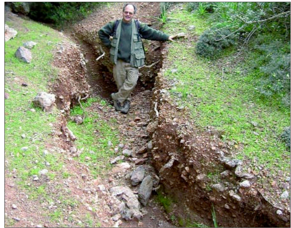
Fotografia 22 - Problemes d'erosió associats a l'obertura de pistes.
