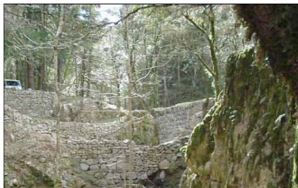
Photo 24 - Béal en aval de la grande gourgue de la Vallée Obscure.
