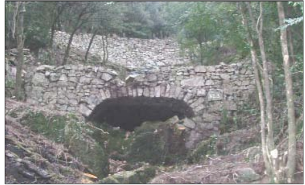
Photo 26 - Bassin-source sous voûte dans la partie inférieure du valat V2.
