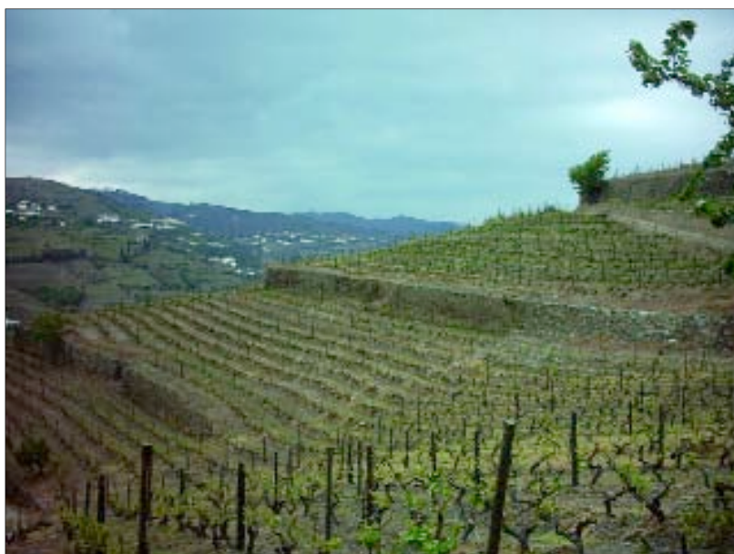
Fotografia 6 - Muro de pedra em seco reconstruído.
