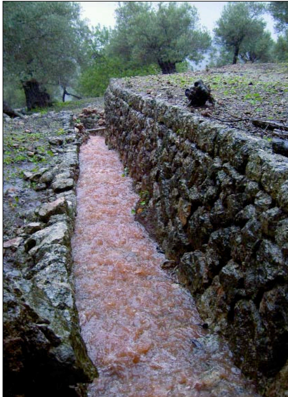
Fotografia 5 - Ralla de drenatge d'un camp marjat.
