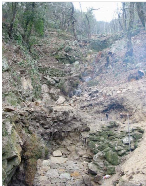
Photos 21 - Réhabilitations de tancats sur un affluent (V2) du ruisseau de Valescure : état des travaux en mars (à gauche) et en août (à droite) 2005.
