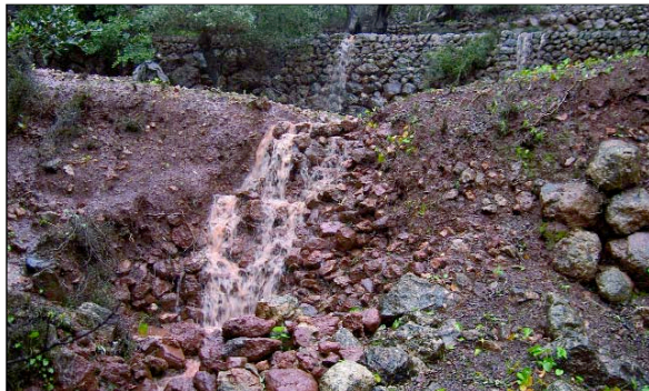
Fotografia 18 - Degradació del sistema a Cas Bernats.
