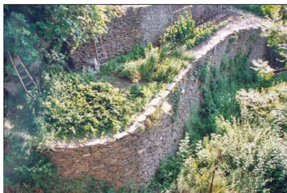
Photo 13 - Murs de terrasses réhabilités sur le site des Calquières à Saint-Germain-de-Calberte (Lozère).
