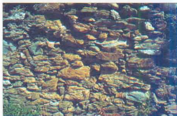
42. Exemple de marge amb paredat de blocs de margues sense adobar (Cinque Terre, Ligúria).
