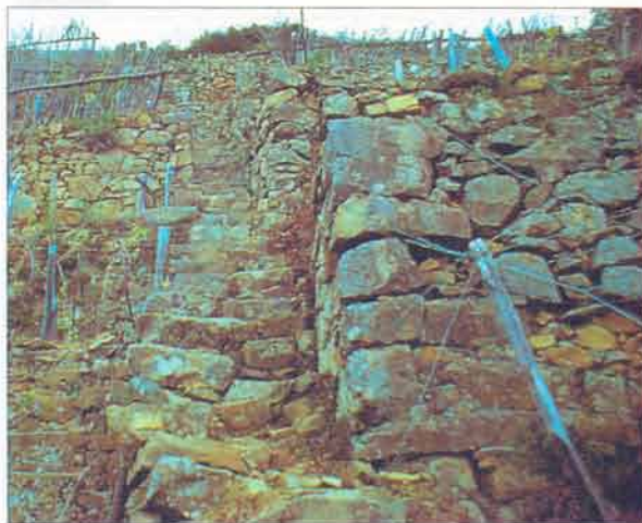
177. Esempio di scala frontale in blocchi di arenaria integrata nei terrazzamenti.
