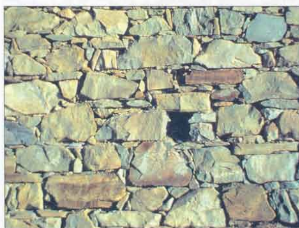
49. Exemple de paredat adobat bastit amb pedra arenosa (Cinque Terre, Ligúria).
