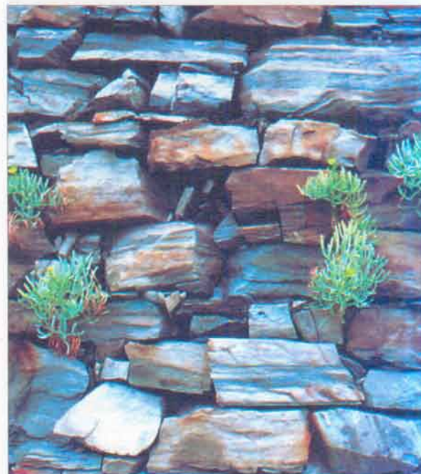
43. Marge de paredat poc adobat, bastit amb blocs de siltites (Cinque Terre, Ligúria).
