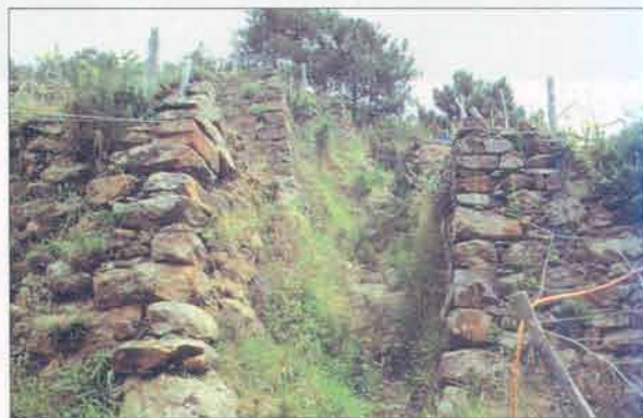
79. Exemple de canalització encaixada entre murs de lloses (Cinque Terre, Ligúria).
