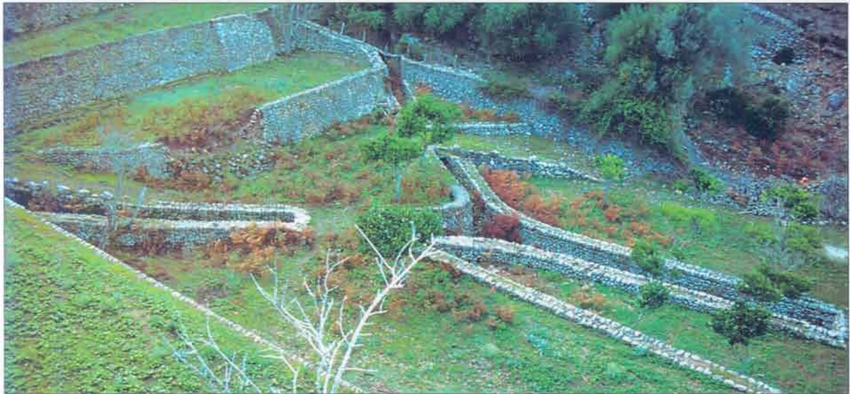
82. Canalitzacions a la zona de confluència de dos torrents (Escorca, Mallorca).
