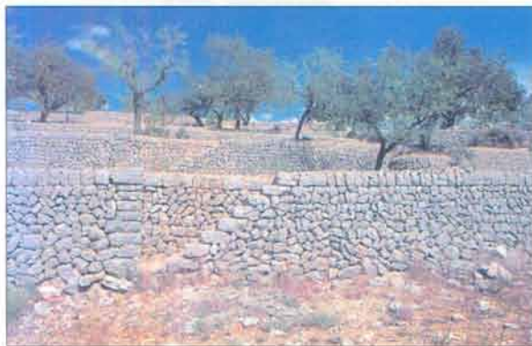
150. Escales laterals integrades de Can Jaumico.
